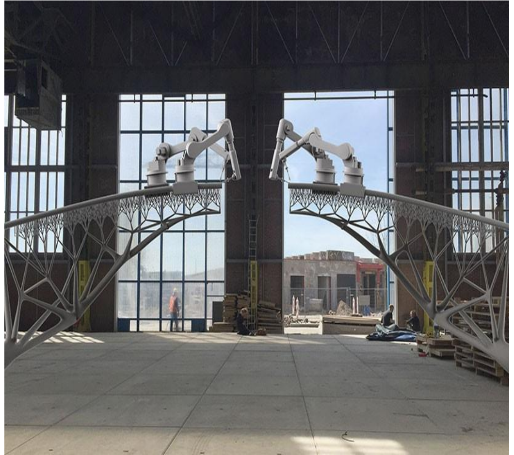
Xây cầu tự động bằng in 3D
